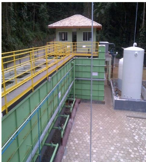
Figura 7.39 – ETA Pedra Branca Fonte: Águas de Paraty, 2021
