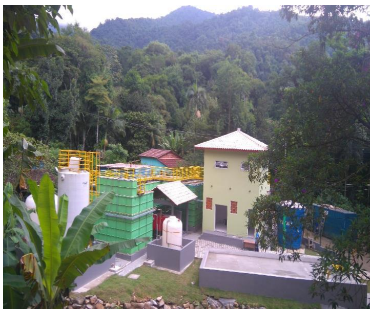
Figura 7.41 – ETA Corisquinho Fonte: Águas de Paraty, 2021
