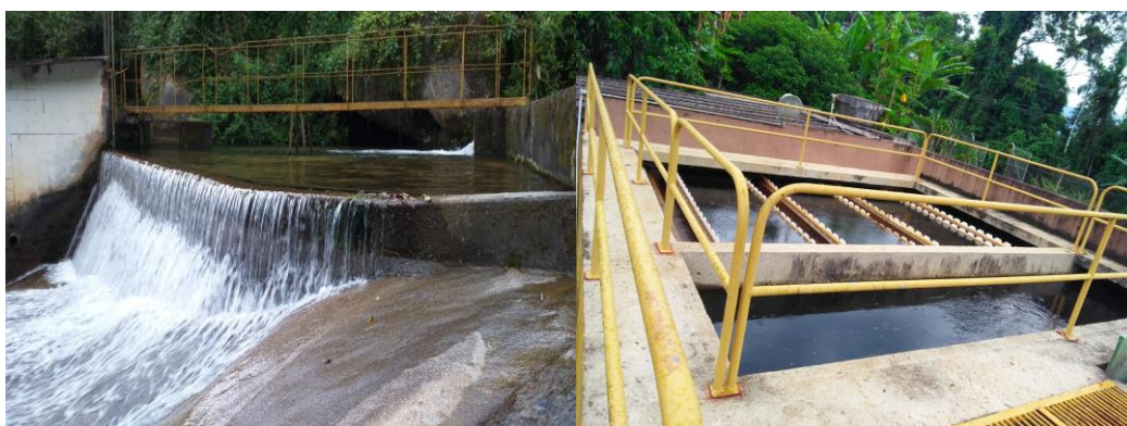
Figura 7.3 – Captação e ETA Mambucaba (Vila Residencial de Mambucaba)
