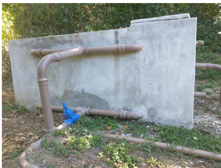
Figura 7.18 – Desarenador (Graúna)
