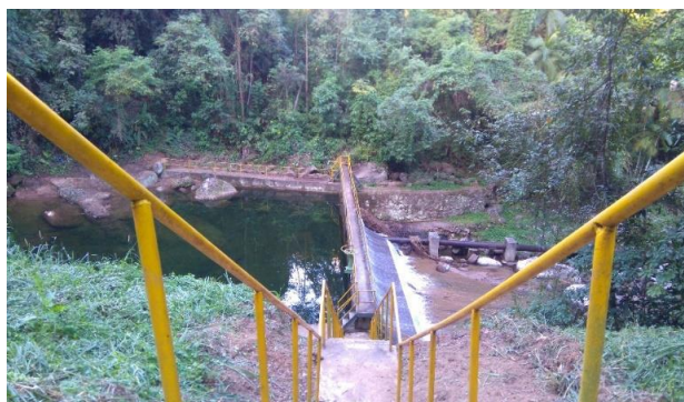
Figura 7.37 – Captação Pedra Branca Fonte: Águas de Paraty, 2021
