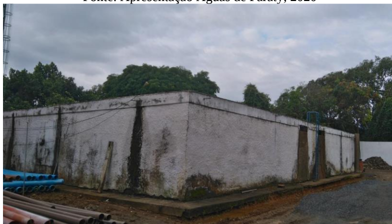
Figura 7.34 – Reservatório Caborê Fonte: Apresentação Águas de Paraty, 2020
