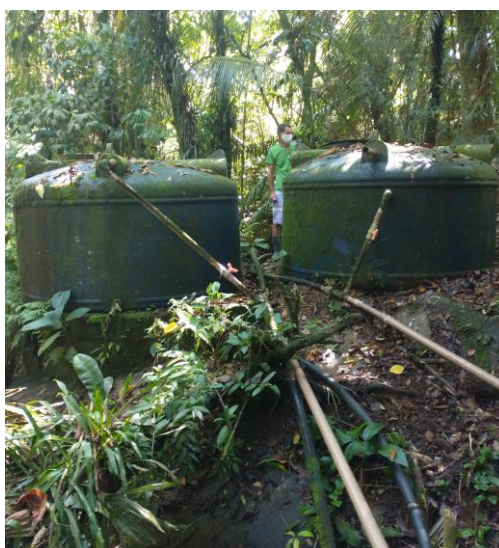
Figura 7.1 – Reservatórios (Chapéu do Sol – Parque do Sol Nascente)
